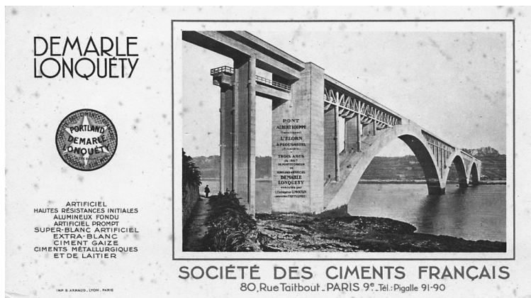
Fig. 4. Cartolina réclame dell'Impresa Demarle-Longuëty: sulla sinistra elenco dei cementi prodotti; al centro, il Ponte di Plougastel, progettato da Freyssinet e costruito tra il 1926 e il 1930 dall'Impresa Limousin.
