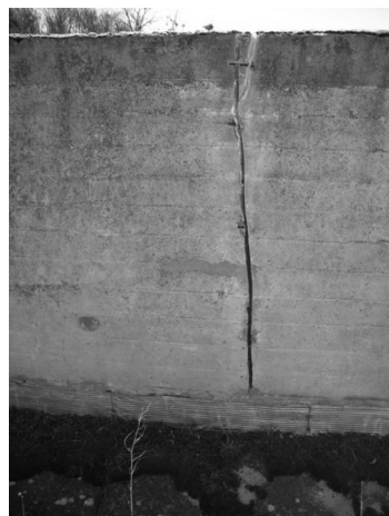
Fig. 8. Convento di Sainte-Marie de la Tourette, muro di recinzione del tetto terrazza della chiesa, lesione iniettata con schiuma poliuretanica, sigillata con resina epossidica e parzialmente 'cucita' con elementi metallici, durante i lavori di restauro del 1981 [foto dell'a., 2010]
