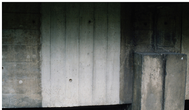
Tav. I. Saggi di pulitura con impiego di laser (L1, L2, L3, L4) e sabbiatura fine (Q1, Q2); in basso, saggio di pulitura con impacchi di attapulgit [Cahier technique du Cercle des Partenaires du Patrimoine 2009].
