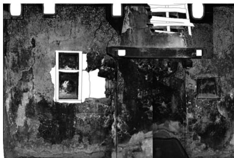
Fig. 1. Interno con evidenti incrostazioni bituminose sulle pareti.
