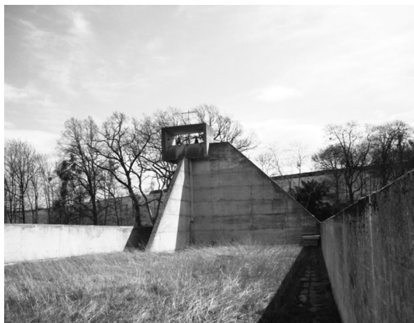
Fig. 7. Convento di Sainte-Marie de la Tourette, muro in calcestruzzo armato che cinge il tetto-terrazza della chiesa. Gettato senza giunti, il muro presenta lesioni verticali a intervalli regolari [foto dell'autore, 2010]
