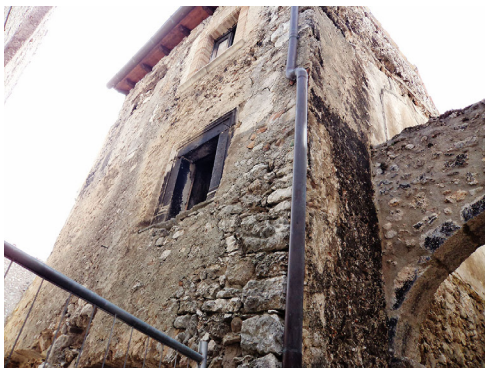
Tav. X. Aspetto delle patine ad ossalati sulle superfici di un edificio a confronto con una simulazione di un possibile intervento di restauro che attenui l'alterazione cromatica senza rimuoverle del tutto.
