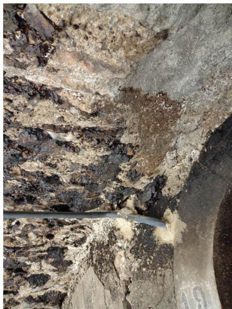
Tav. IX. Aspetto di un sottovolta incrostato da materiale bituminoso a confronto con una simulazione di un possibile intervento di restauro che mantenga lo status quo eliminando solo le incrostazioni più decoese.
