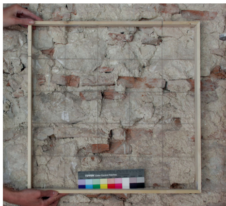
Tav. III. Muratura pertinente alle riparazioni successive al sisma del 1703, con paramento a filari alternati in mattoni e bozze calcaree.
