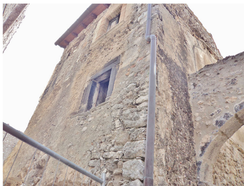
Tav. X. Aspetto delle patine ad ossalati sulle superfici di un edificio a confronto con una simulazione di un possibile intervento di restauro che attenui l'alterazione cromatica senza rimuoverle del tutto.
