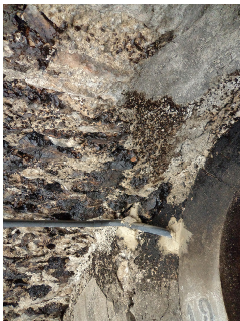
Tav. IX. Aspetto di un sottovolta incrostato da materiale bituminoso a confronto con una simulazione di un possibile intervento di restauro che mantenga lo status quo eliminando solo le incrostazioni più decoese.
