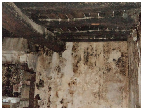
Tav. VIII. Aspetto di un intonaco incrostato da materiale bituminoso in un interno a confronto con una simulazione di un possibile intervento di restauro che ripristini lo scialbo.
