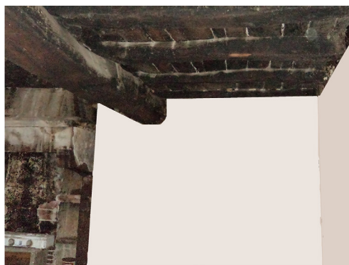
Tav. VIII. Aspetto di un intonaco incrostato da materiale bituminoso in un interno a confronto con una simulazione di un possibile intervento di restauro che ripristini lo scialbo.
