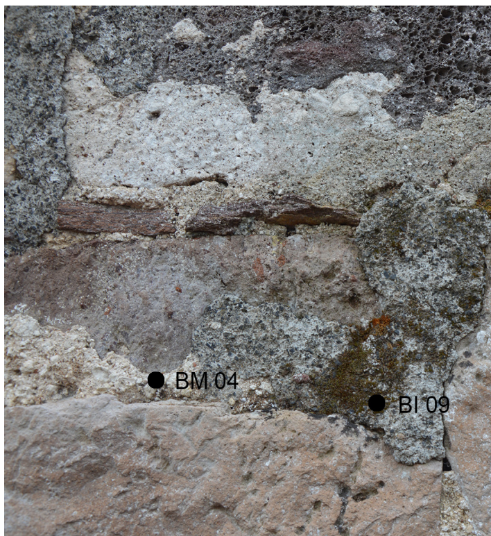
Tav. V. Prospetto nord, stratigrafia 3. Si noti il campione BM04, residuo della stesura in età moderna della malta di protezione dei giunti con la tecnica raso-pietra.
